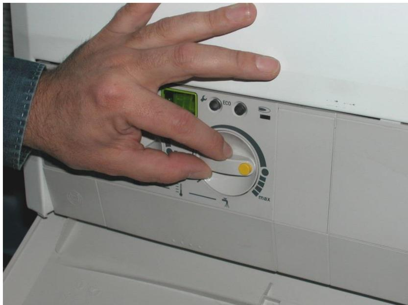
**Figura 10 Puesta a máxima potencia de los aparatos**
